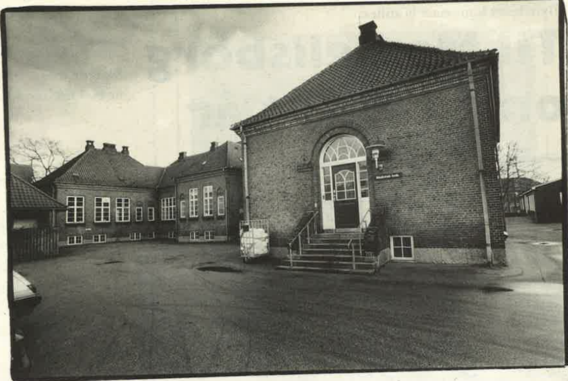
Muskelsvindfondens blivende domicil fra 1998. Bygning 7 på Marselisborg Hospital.
