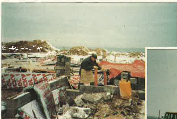
Fundamenterne til de første ferielejligheder er blevet støbt på grunden ved Musholm Bugt.
