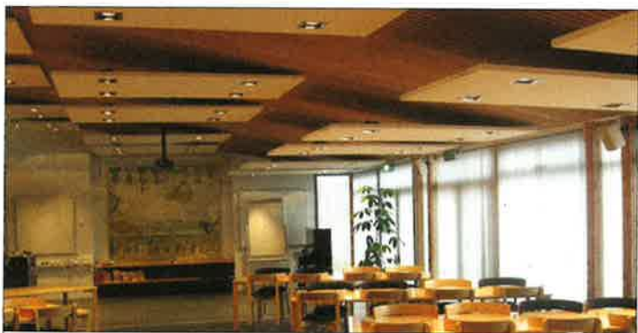
Lyddæmpende plader er blevet monteret i loftet i samlingssalen for at give en bedre akustik.
