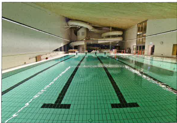
Vandhallas 25 meter svømmebassin har konkurrencefaciliteter og for enden af hallen en 90 meter vanddrutsjebane.
