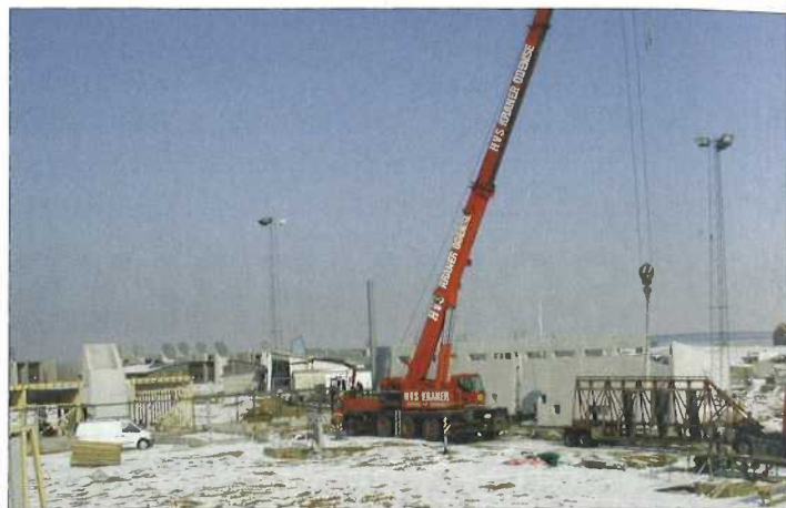
I begyndelsen af marts blev betonelementerne til det nye aktivitetshus monteret ved hjælp af en kæmpekran.
