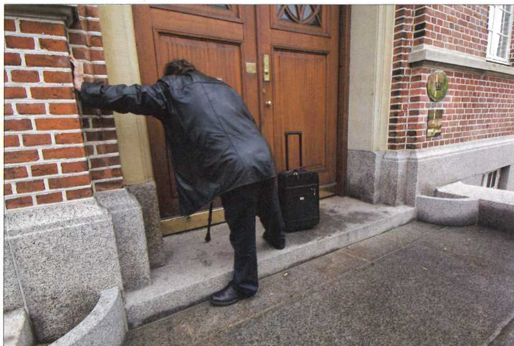
Advokat Peter Bach-Nielsen bruger mange kræfter på at komme ind i Retten i Århus. Adgangsforholdene er håbløse for gangbesværede.
