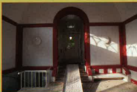
Marselisborgcentret er ved at udvikle sig til den rehabiliteringspark, der hele tiden har været visionen. Tilgængeligheden er dog ikke alle steder lige optimal som her i portrummet i den gamle hovedbygning, hvor besøgende må forcere en stejl rampe for at komme ind. Foto: Ole Hein Pedersen.
