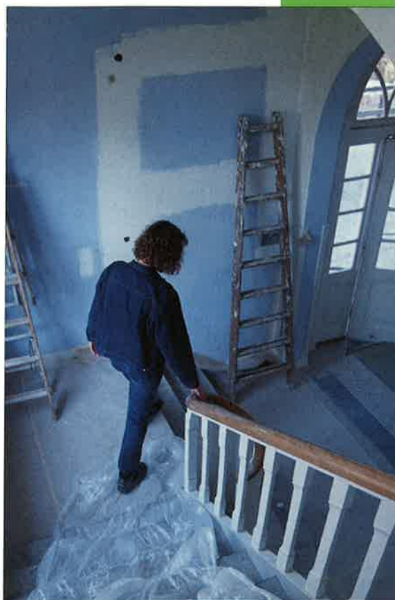
Flytterod og renoveringsarbejde præger endnu mange bygninger i MarselisborgCentret
