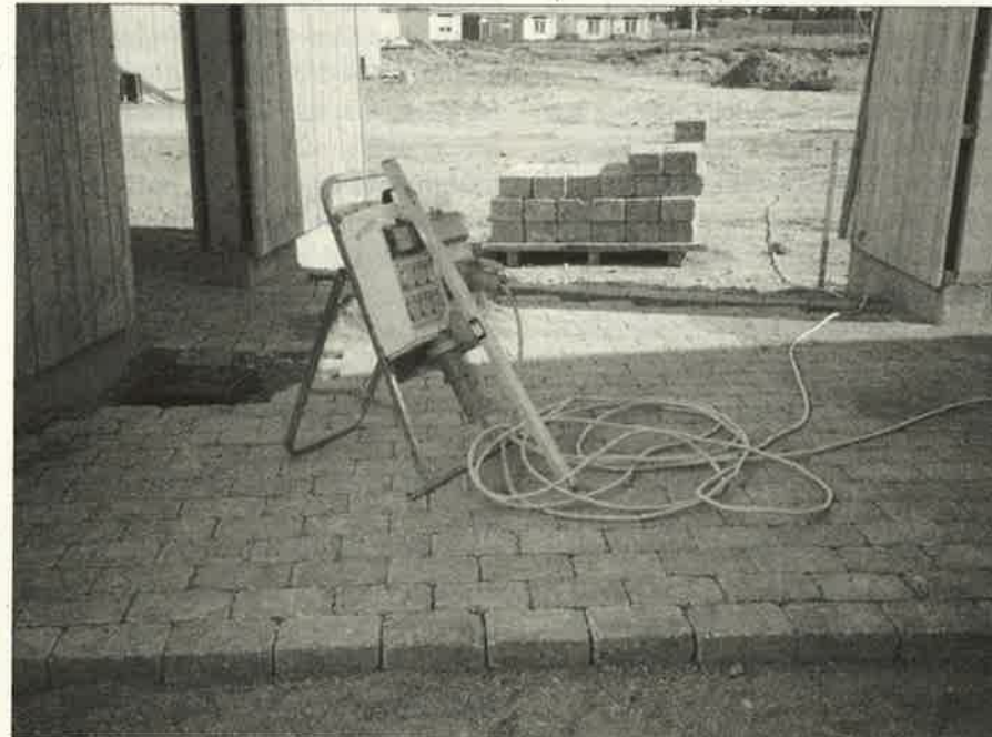
Anlægsgartnere er i fuld gang med at lægge fliser på stierne og anlægge terrasserne ved ferieboligerne.
