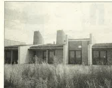
De økologiske principper er gennemgående i byggeriet af feriecentret blandt andet ved brug af naturlige byggematerialer som thujatræ til den udvendige beklædning og græs på taget.
