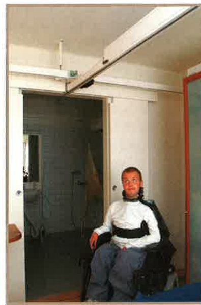
Det ærgrer Søren V. Knudsen, at entreprenøren havde glemt at installere liften. Resultatet er, at liftsystemet nu er meget synligt.
