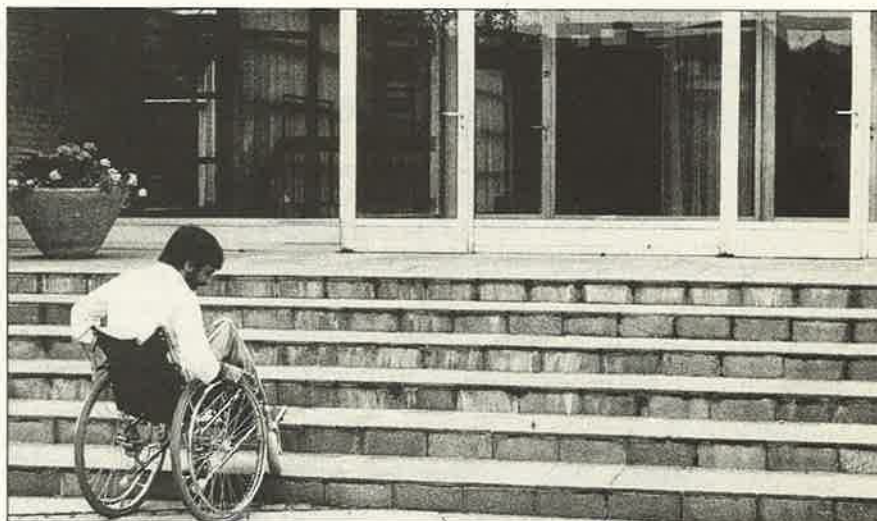
Holder det da aldrig op? Nej, bygningsreglementet overtrædes til stadighed. Selv i moderne byggerier, som påstår at ville integrere handicappede, er der talrige eksempler på fejl og overtrædelser af reglementet, som giver store gener for bevægelseshæmmede. (Arkivfoto)
