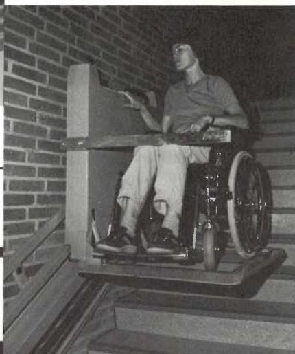
Lift i drift - betjeningen kan, som her, ske fra selve liften, men kan også ske fra betjeningspanelet, der er placeret foroven og forneden på væg.
