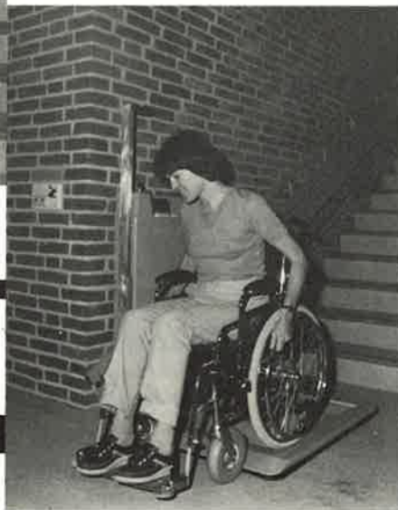
Lift klar til afkørsel - sikkerhedsarmen er slået op.
