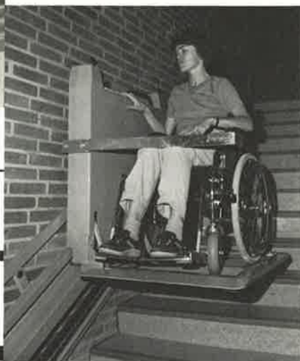
Lift i drift - betjeningen kan, som her, ske fra selve liften, men kan også ske fra betjeningspanelerne, der er placeret foroven og forneden på væg.
