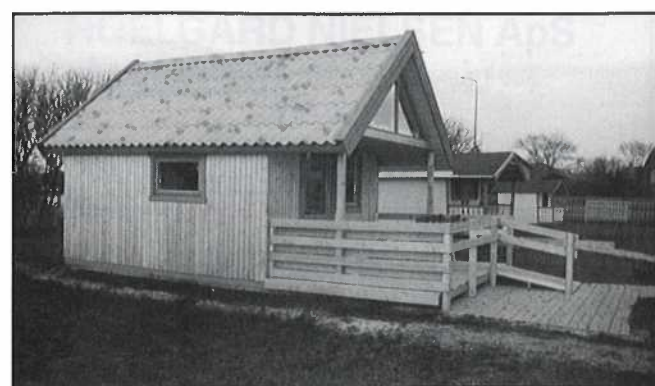
Campinghytterne er større end normalt, dørene er bredere og der er flere sovepladser. Soverummet er adskilt fra opholdsrum, og de øverste køjer kan vippe op. Der er direkte adgang fra hytten til et stisystem via en rampe fra husets terrasse. Endelig er hytterne placeret tæt på toiletbygningerne, hvor der er tre handicaptoiletter.
